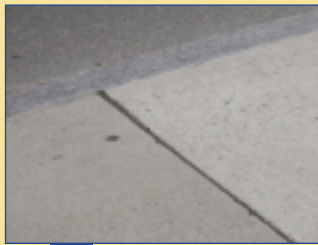
Jointis sciés et scellés
