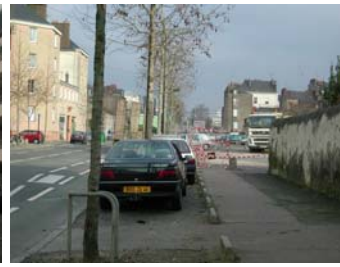
3 : Travaux sur le trottoir
